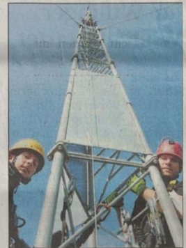
Wird 140 Meter hoch: Der Windmessmast bei Wolfhagen. Jewgeni Fux (links) und Nils Wagner von der Firma Ge:Net aus Clausthal-Zellerfeld bauen den Stahlturm auf.
